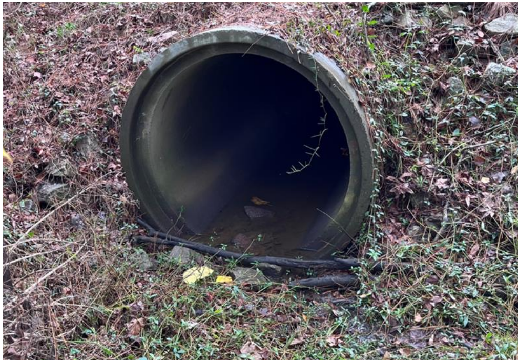
Culvert 5 (Sta 6047+30) US Inlet
