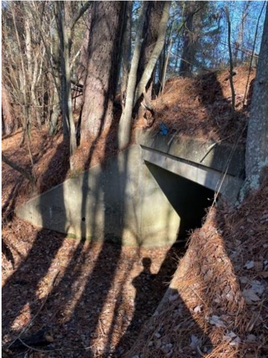
Culvert 1 (Sta 3145+00) US Inlet
