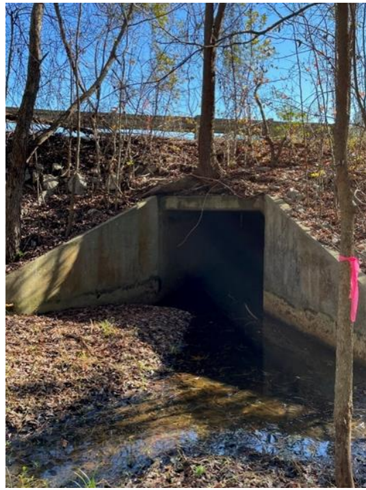
Culvert 2 (Sta 6022+50) US Inlet
