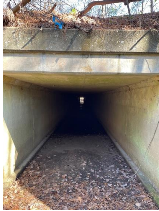
Culvert 1 (Sta 3145+00) US Inlet
